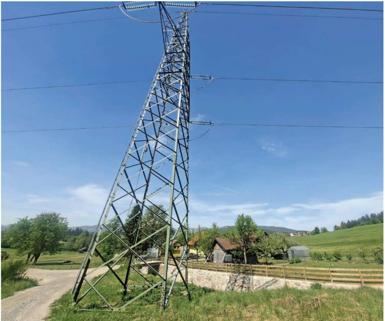
Hiša Vesne Junger v Kotljah, v ozadju daljnovoda, stoji v varovalnem pasu, ki je bil ob spremembi predpisov razširjen.
